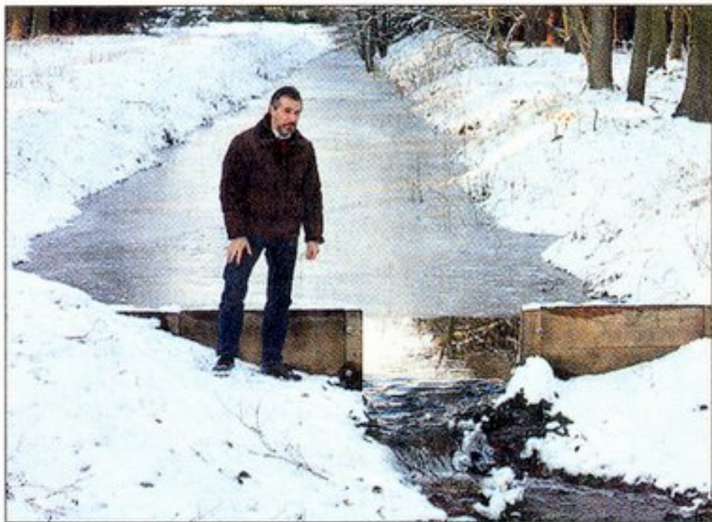
Durch die Sohlswellen hat sich das Grabenbett wieder gefüllt, das vor Jahren noch ausgetrocknet war. Foto: Kluge
